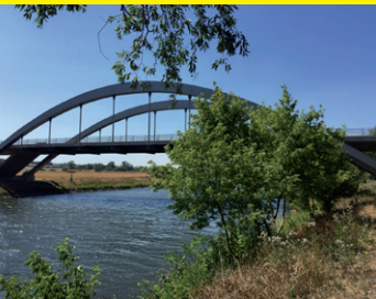
Brücke über die Saale bei St. Georg.
